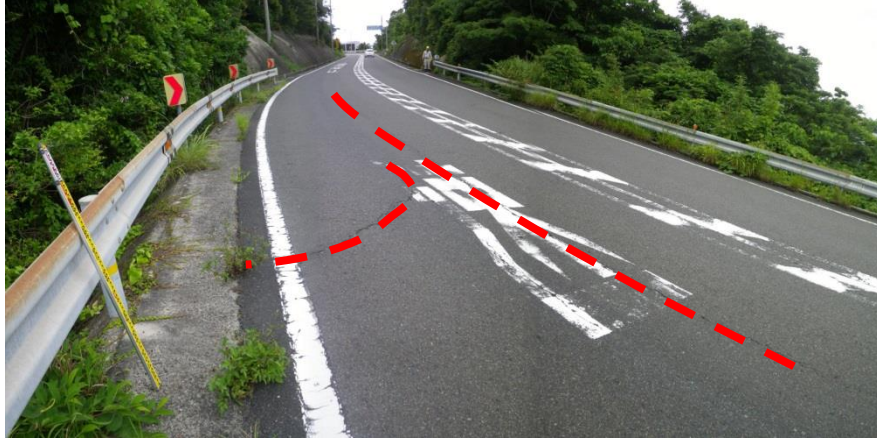
路面に円弧状の亀裂有り
